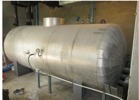
สภาพเครื่องกำเนิดน้ำร้อน (Boiler)
