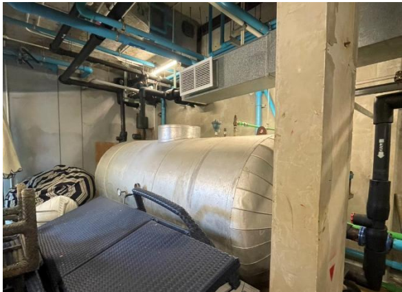
สภาพเครื่องกำเนิดน้ำร้อน (Boiler)
