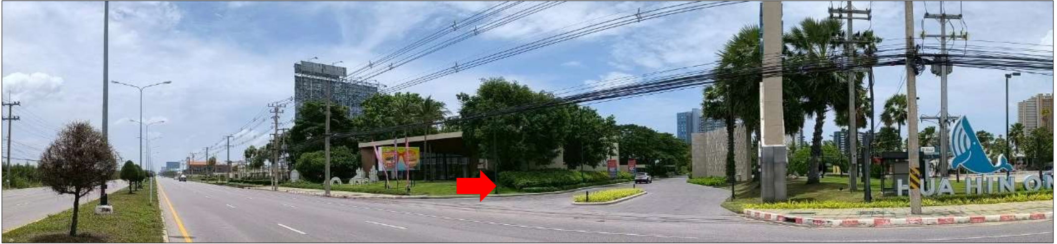
สภาพถนนเพชรเกษม (ทล.4) บริเวณหลักกิโลเมตรที่ 196+100 แยกเข้าซอยโครงการทิวทะเล ทางเข้าที่ตั้งทรัพย์สิน (จุดถ่ายภาพที่ 3)
