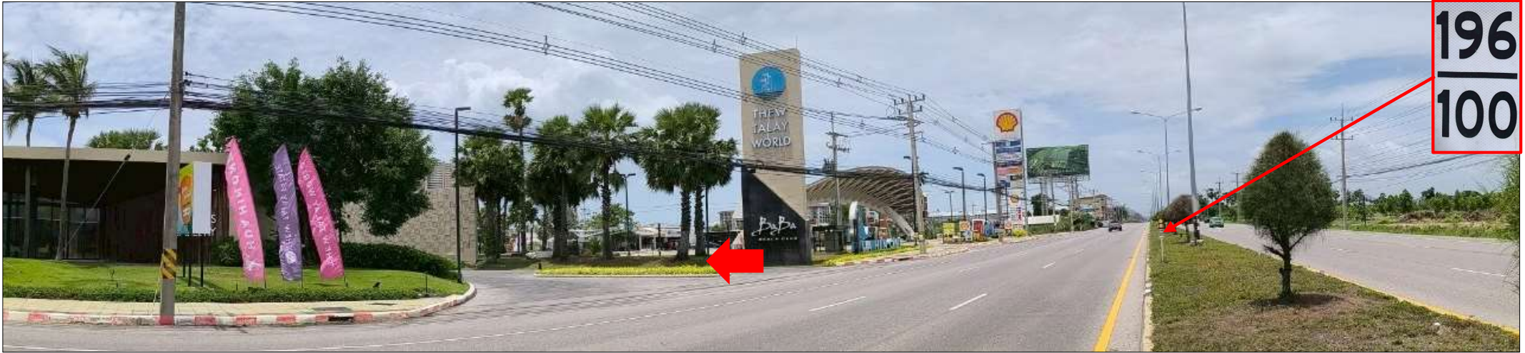
สภาพถนนเพชรเกษม (ทล.4) บริเวณหลักกิโลเมตรที่ 196+100 แยกเข้าซอยโครงการทิวทะเล ทางเข้าที่ตั้งทรัพย์สิน (จุดถ่ายภาพที่ 1)
